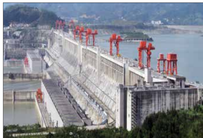
Barrage des Trois-Gorges en Chine.
